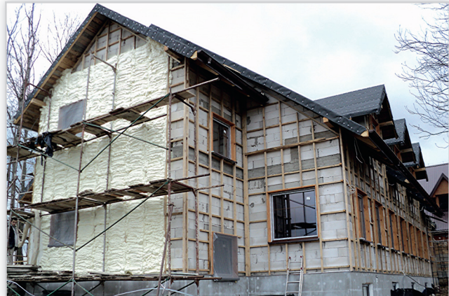
Ocieplenie ścian zewnętrznych. Pianka natryskowa H_Foam Lite może być również stosowana jako izolacja zewnętrzna ścian. W tym przypadku musi zostać zasłonięta niezależnym wykończeniem elewacji budynku, np. sidingiem (oblicówka). Przed zamontowaniem warstwy paneli, piankę należy przykryć folią paroprzepuszczalną. Tak ocieplona ściana zewnętrzna pozostaje przegrodą paroprzepuszczalną, potocznie mówiąc „oddychającą”.
