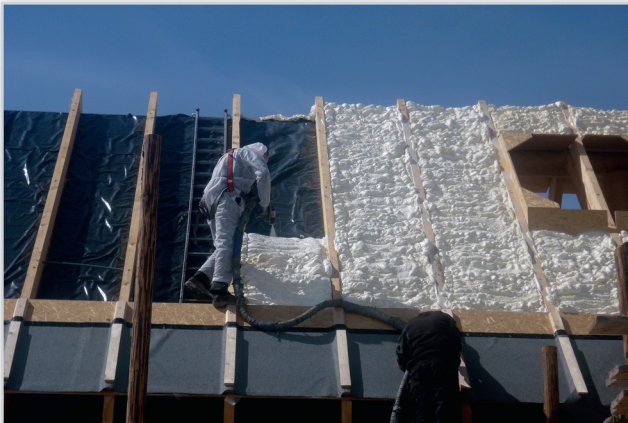
Izolacja dachu od zewnątrz. Pianka kanadyjskiego producenta ICYNENE to doskonały sposób na szybką i komfortową wymianę starej, nieskutecznej izolacji termicznej od strony zewnętrznej bez konieczności ingerencji w część mieszkalną obiektu. To również doskonały materiał na termomodernizację budynków, w których nie zastosowano wcześniej izolacji.
