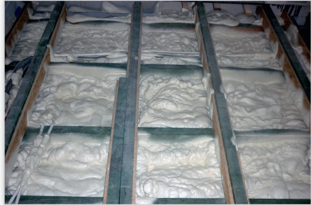
Ocieplenie stropu. Poza znakomitymi właściwościami termicznymi izolacja H_Foam Lite wyróżnia się bardzo dobrą dźwiękochłonnością. Pianka może być stosowana jako dodatkowa warstwa dźwiękoizolacyjna, poprawiająca izolacyjność akustyczną budynku, w tym także stropów i podłóg. Może być nanoszona na strop międzykondygnacyjny zarówno z dołu jak i z góry.
