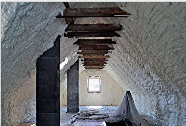
Izolacja domów drewnianych. Ocieplony kompletnie dom drewniany pianką H_Foam Lite jest odzwierciedleniem zdrowego, zharmonizowanego budynku. Pianka kanadyjskiego producenta została stworzona do wykonywania izolacji w bezpośrednim natrysku na podłoże drewniane. Dzięki ciągłości izolacji eliminuje mostki termiczne odpowiedzialne za straty ciepła oraz wykraplanie się pary wodnej.
