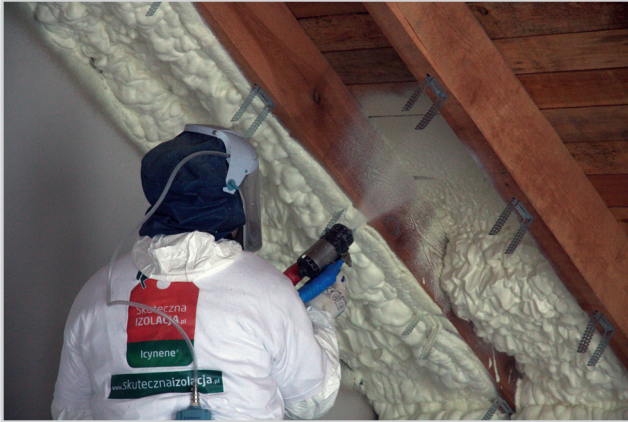
Ocieplenie poddasza. Pianka H_Foam jest doskonałym materiałem na skuteczną izolację poddasza. Może być nanoszona bezpośrednio na płytę OSB, deski czy nawet folię paroprzepuszczalną. Jest lekka i elastyczna, dzięki czemu nie obciąża dachu i pracuje razem z drewnianą konstrukcją. Jest nieprzewodnym i paroprzepuszczalnym materiałem.
