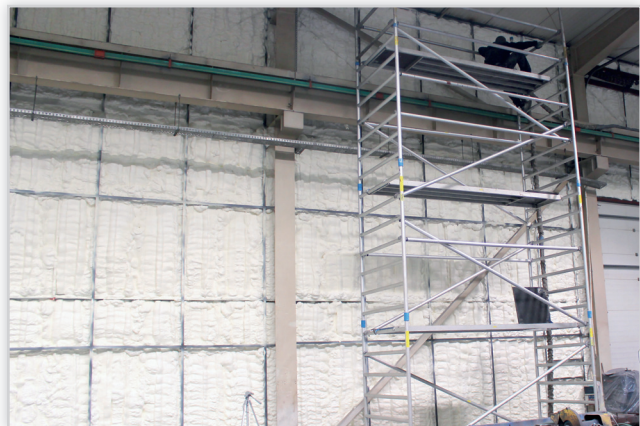
Izolacja obiektów przemysłowych. Dzięki swej niewielkiej wadze 8,3 kg/m 3 pianka H_Foam Lite jest idealnym rozwiązaniem na ocieplenie lekkich blaszanych konstrukcji. Już przy 15 cm grubości izolacja ICYNENE redukuje przepływ ciepła w 96%. Doświadczony Autoryzowany Wykonawca jest w stanie wykonać nawet 400 m 2 izolacji w ciągu 1 dnia, skracając czas prac budowlanych, jak również czas przestoju produkcji.
